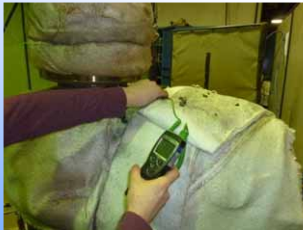
Stetige Überprüfung und Dokumentation der Schweißparameter (Zwischenlagentemp., Stromstärke, Wärmeeinbringung)
