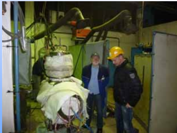
Kantenversatzkontrolle und Freigabe zum Schweißen mit BS und VE-G an der ersten Naht.
